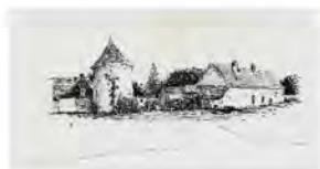
Beaupré avant la restauration
