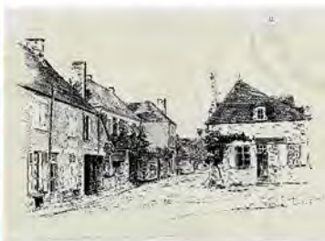
La maison au toit pointu du XVII e siècle et à la jolie lucarne fut le salon de M. Guérin coiffeur.
