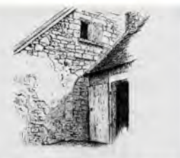
La Saulnerie, porte et fenêtre du X e siècle
