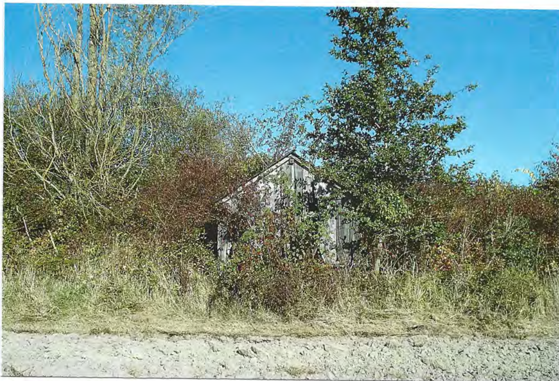
Dans le champ situé à l'embranchement de la route de Mézières et de la route du Moulin Neuf, cette loge est à demi cachée par la haie photo 2021
