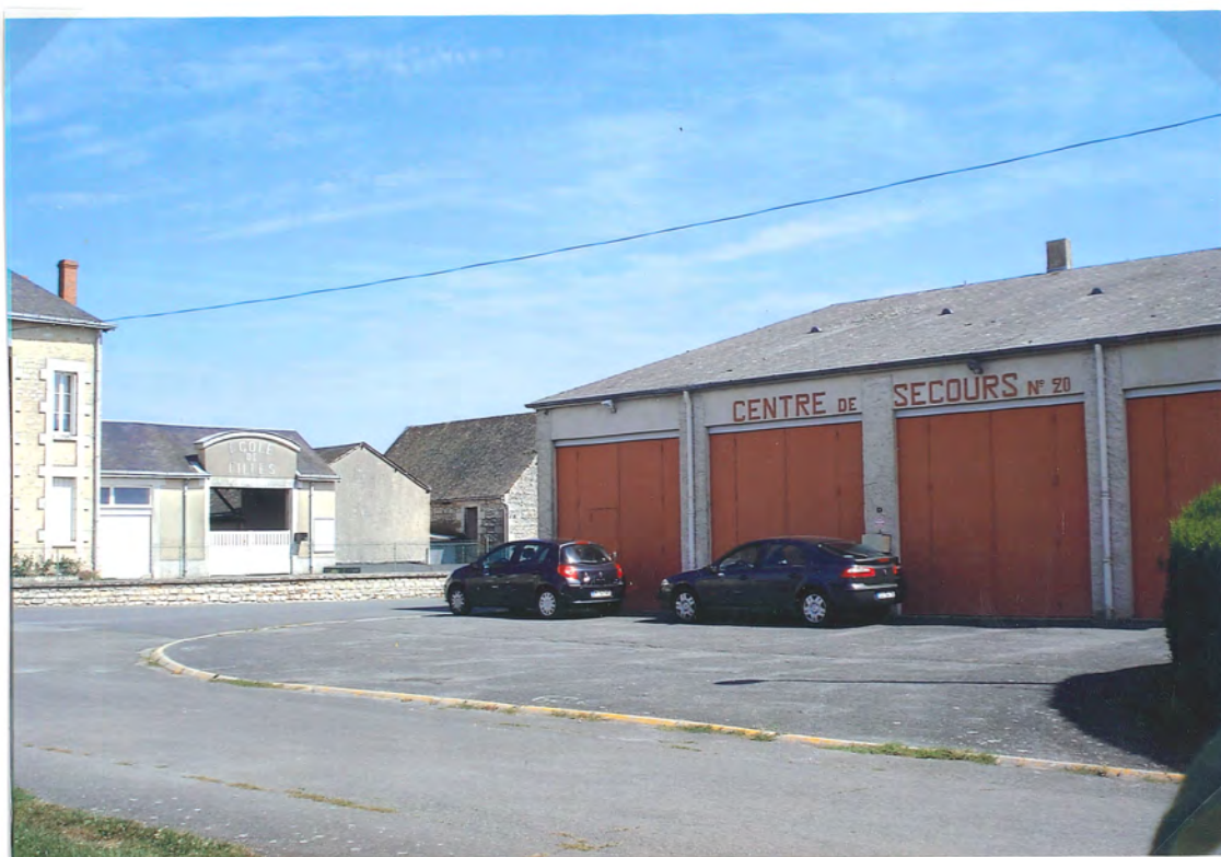
Ancien centre de secours
